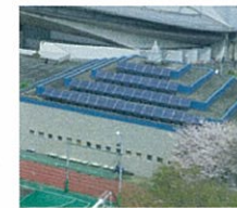
太陽光発電設備
